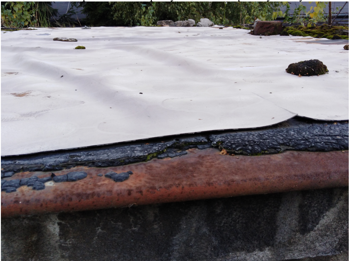
Fot. Nr 14 Widok połaci dachu – pokrycie z płyt
