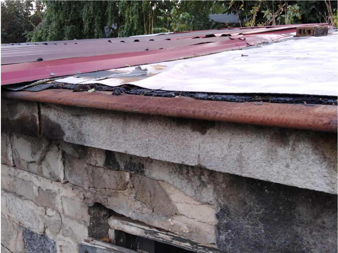
Fot. Nr 13 Widok połaci dachu – pokrycie z blach trapezowych i wykładzin
