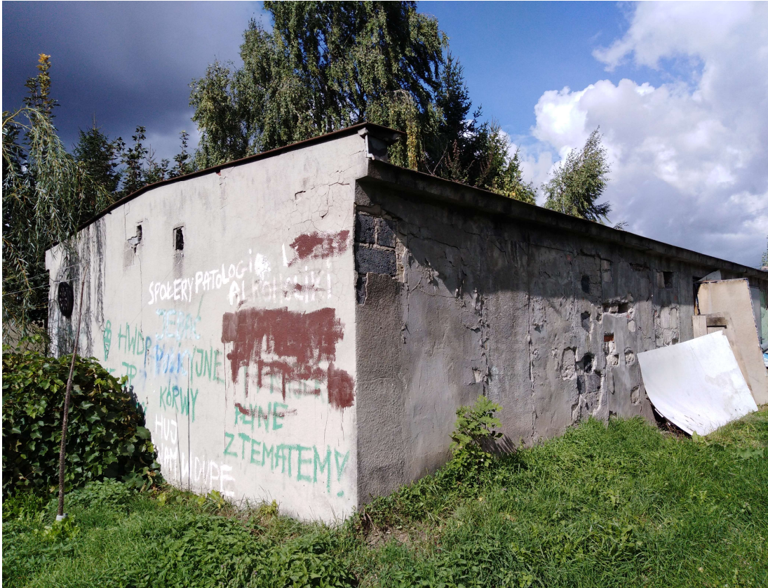
Fot. Nr 3 Elewacja południowo-wschodnia - widok od strony południowej
