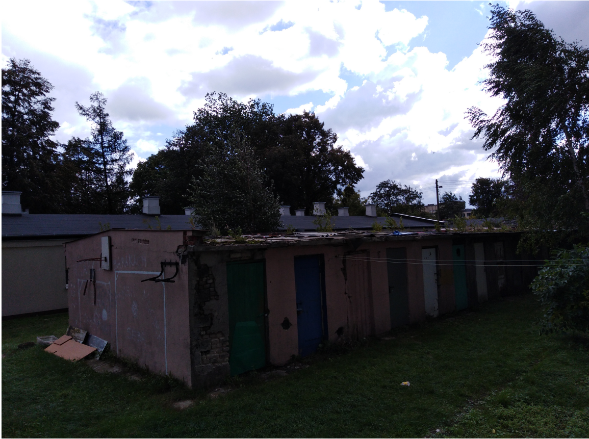
Fot. nr 1 Elewacja północno-zachodnia
