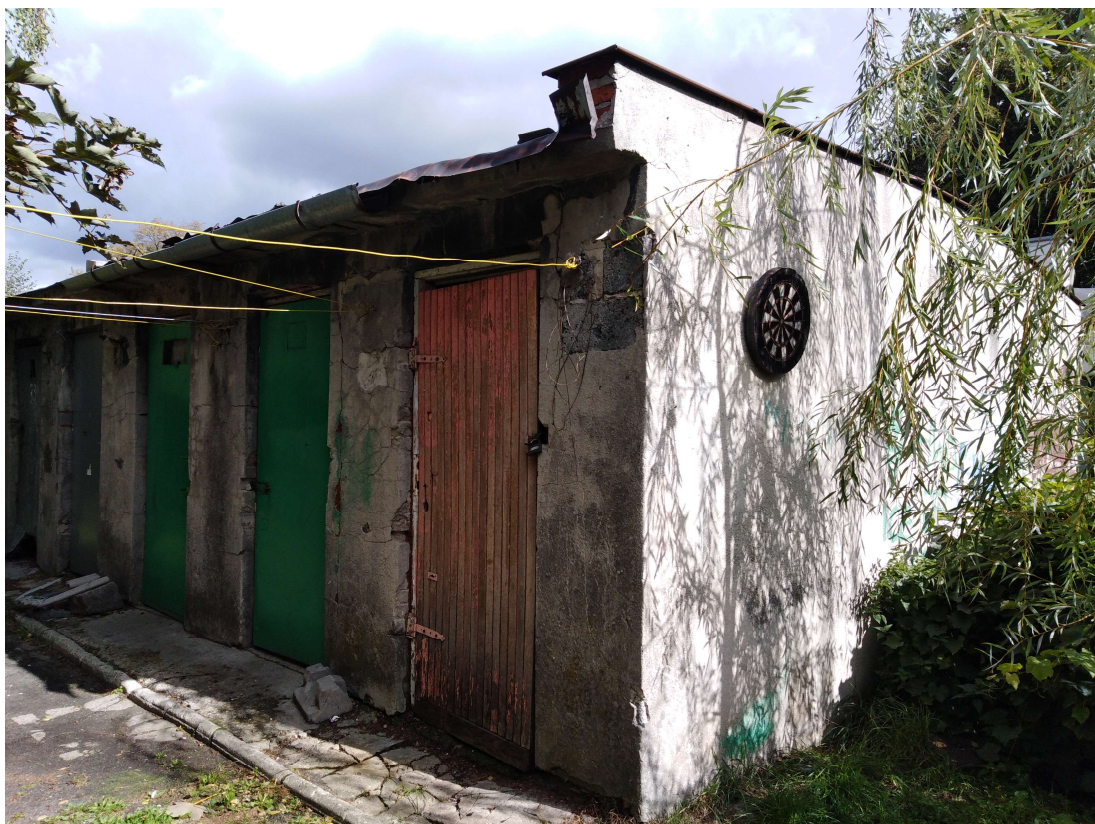
Fot. nr 4 Elewacja południowo- zachodnia - widok ogólny od strony południowej
