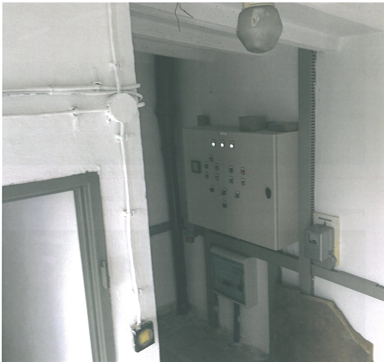
Zdjęcie nr. 4. Widok jednej z szaf sterowniczych studni głębinowych.
